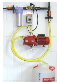
Öffnen des entsprechenden Abteilhahnes. Einschalten der Pumpe bis Behälter geleert ist. Entsprechend der Leitungslänge Wasser in Behälter einfüllen (meist 10 L ausreichend) und Leitung leer spülen.
