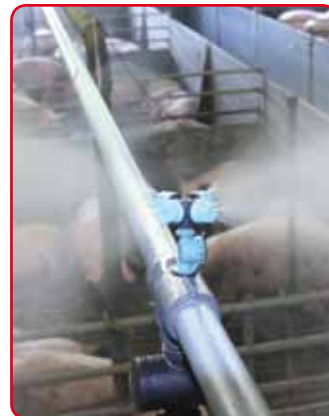
Kühlung im Maststall
